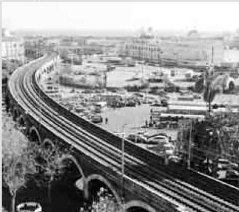
GLI ARCHI DELLA MARINA E LA FERROVIA IN ZONA PORTO
